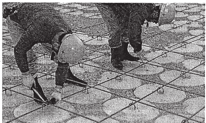
写真3-15 連結筋の上部に結束
