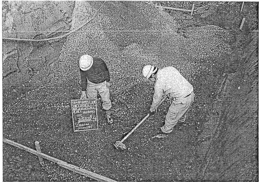
写真3-2 ジョレンによる碎石の均し
